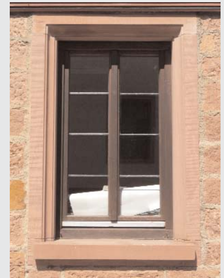
zweiflügliges Holzfenster mit Bleisprossung
