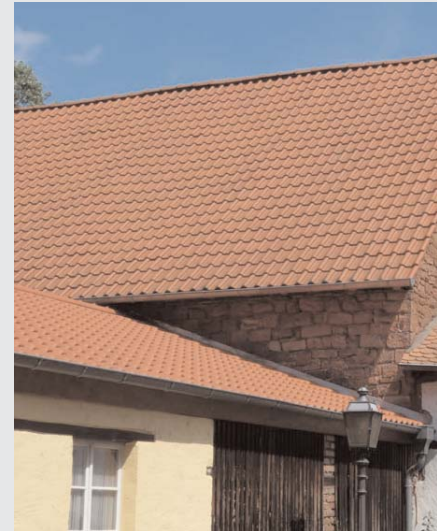
ruhige Dachfläche in Tonfalz
