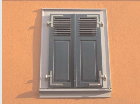
Fensterumrandung bei gedämmter Fachwerkfassade
