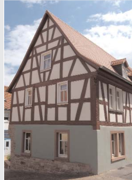
konstruktives Fachwerk, zurückhaltende, rotbraune Balkenfarbe
