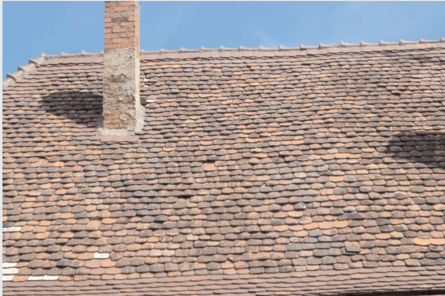
lebendige alte Dachfläche
