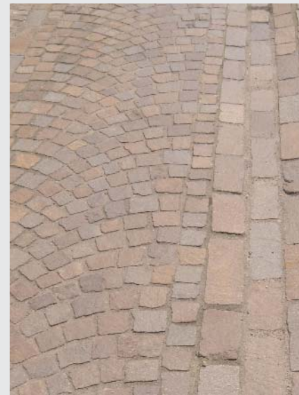
Rinne mit Anschluss, kleinformatiges Bogenpflaster
