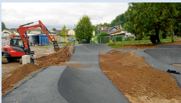
So sah es bei Baubeginn auf dem Gelände aus. Seien Sie gespannt, was daraus geworden ist ...
